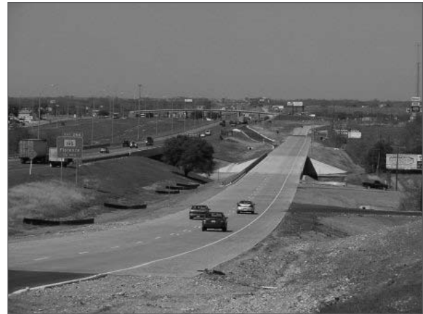
Foto 1. Proyecto ejecutado en la I-35 en Georgetown, Texas.
