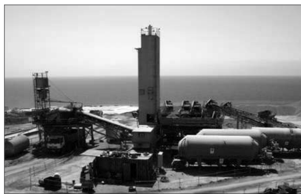
Foto 1. Planta de Hormigón.
