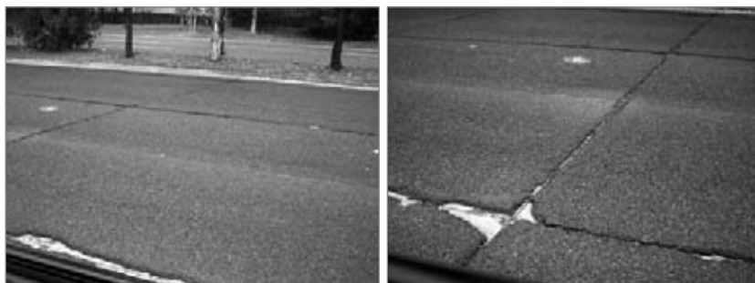
Foto 2. Vista de una capa fina de mezcla bituminosa porosa sobre base de hormigón con juntas que muestra el agrietamiento por reflexión y el desportillado de la mezcla bituminosa.
