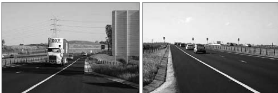
Foto 3. Vista de una capa fina de mezcla bituminosa porosa sobre hormigón armado continuo (CRCP) que está dando buenos resultados y no muestra signos de agrietamiento por reflexión.
