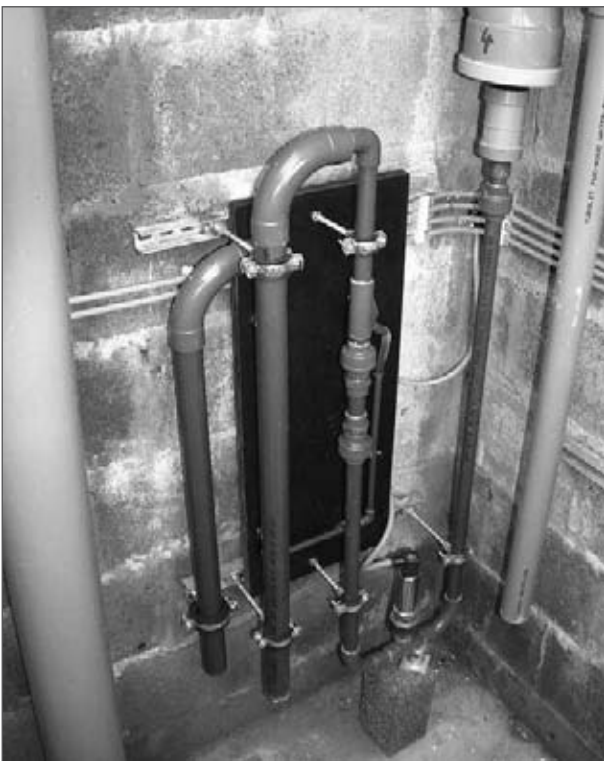
Foto 2. Dispositivo de medida de agua en la parte inferior del firme.
