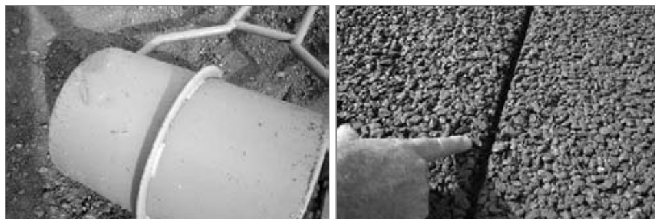
Foto 14 Vistas del dispositivo utilizado para formar las juntas en la capa de hormigón poroso húmedo y junta resultante que se forma.
