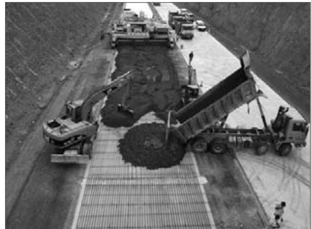
Foto 5. Tren de extendido del hormigón con el pre-extendido y la actuación de la retro giratoria.
