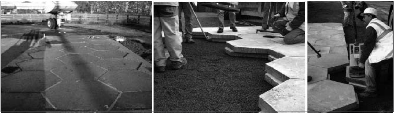
Foto 8. Instalación de losas hexagonales machihembradas en Francia.
