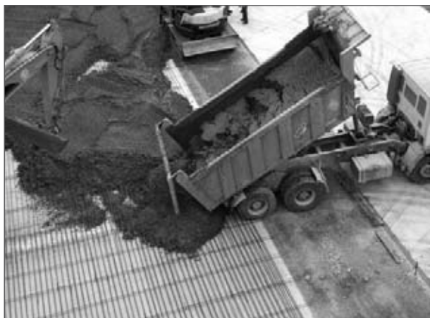
Foto 2. Transporte con camiones volquete.
