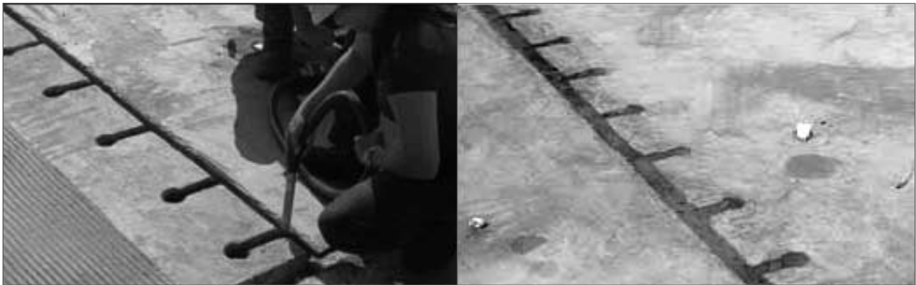
Foto 4. El sistema Kwik Slab.
