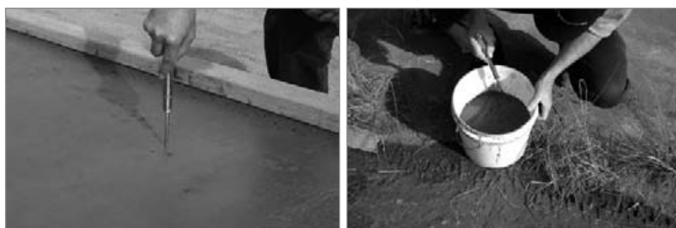
Foto 7. Se probó el penetrómetro de bolsillo para hormigón para determinar el plazo de colocación de la segunda capa tanto en el hormigón in situ (izq.) como en la muestra representativa de mortero (dcha).
