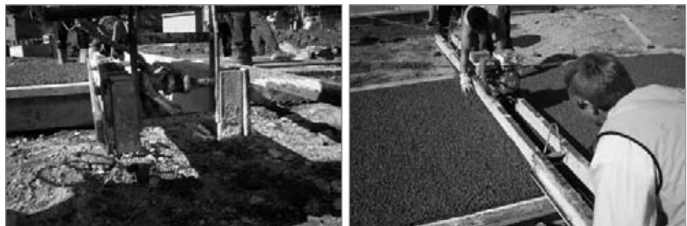
Foto 13. Maestra vibratoria modificada para compactar la capa de hormigón poroso y proporcionar la textura superficial deseada.
