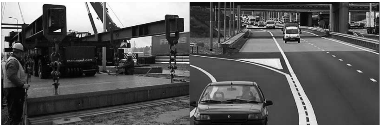
Foto 5. Tecnología ModieSlab en el tramo de pruebas en la A50 y la A12 en los Países Bajos.
