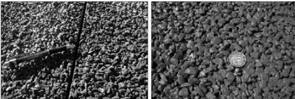
Foto 5. Distintas vistas de la textura superficial del firme de prueba construido con métodos de puesta en obra manual.
