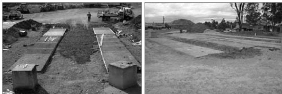
Foto 6 Vistas de la obra de prueba en Sydney occidental justo después de la construcción.
