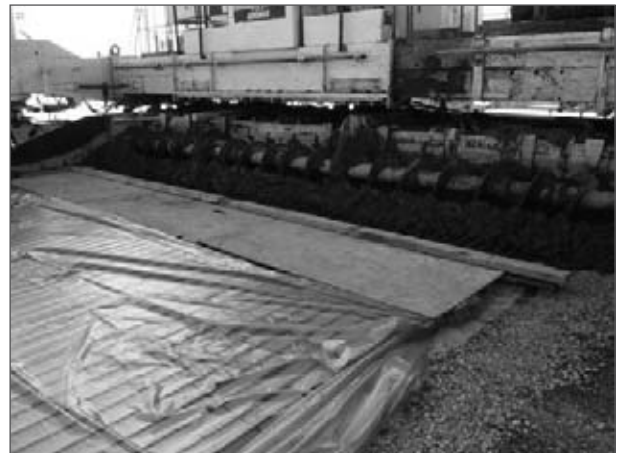
Foto 10. Ejecución de la junta final de día.
