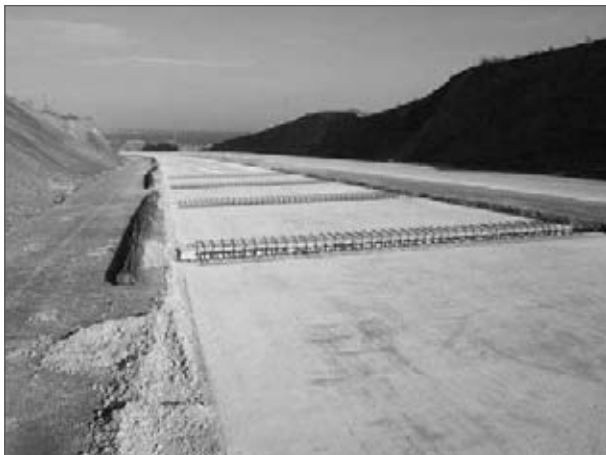
Foto 11. Rastrillos de anclaje.
