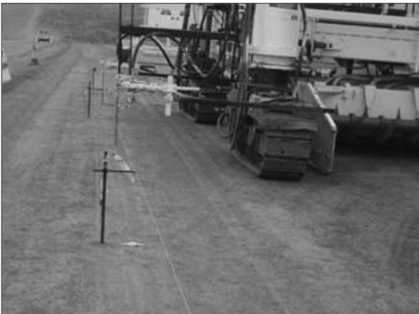
Foto 4. Replanteo de niveles con hilos de guía de los palpadores.
