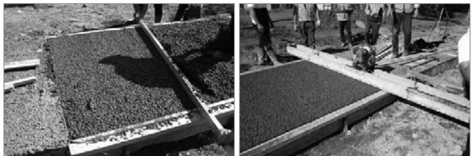
Foto 12. Con el fin de proporcionar suficiente hormigón sin finos para la compactación, se utilizaron encofrados de 12, 15 y 17 mm (izq.) antes de compactar (listones retirados tal como se muestra en la imagen derecha).
