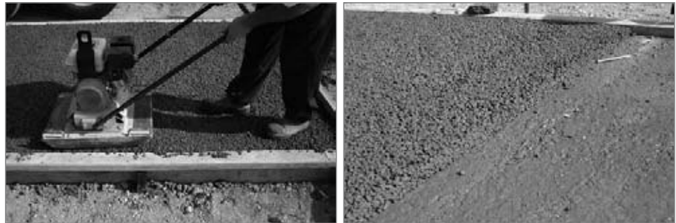
Foto 11. Apareció una onda superficial cuando se utilizó el aparato compactador para losas.
